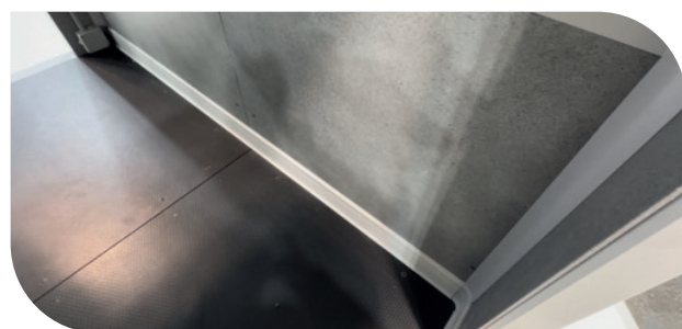
Revêtement intérieur en PVC
