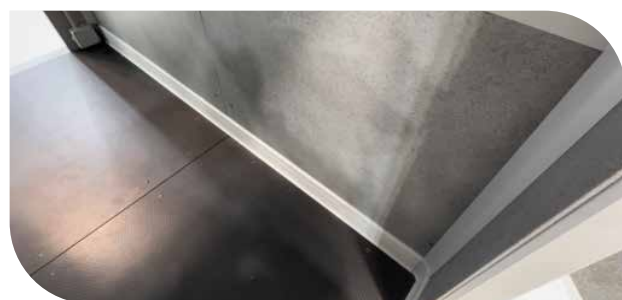
Revestimiento interior de PVC
